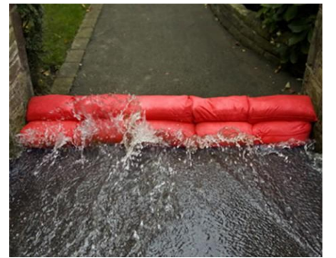
Kum torbası uygulaması örneği
